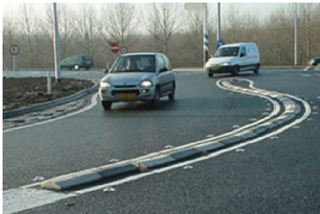
Figuur 2.19 Wegdekreflectoren langs scheidingsband turborotonde
