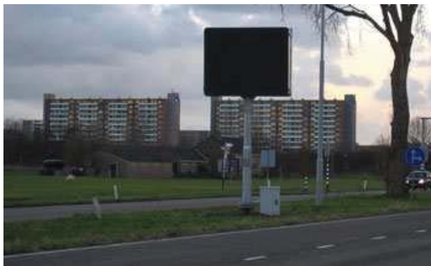
Figuur 12.4 Gecentreerde bevestiging van paneel op draagconstructie
