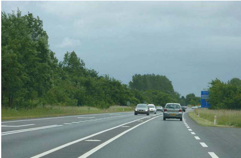
Figuur 2.13 Rijrichtingscheiding op de N206 uitgevoerd in schuin geplaatste broodjes
